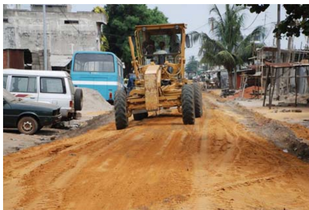
Photo 3 : Rechargement d'une voie érodée Yapélé (cliché : Eténé, septembre 2010).
