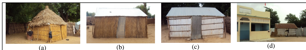
Planche photographique 1 : Evolution du bâti dans la C.R. de Réfane : village de Réo Mao: (a) case simple en paille ; (b) construction en paille et tôle ; (c) construction en tôle et (d), construction en dur ici appartenant à un « émigré italien 1 » équipée d'un panneau solaire pour l'électrification. Clichés : Yanon, juillet 2010.
