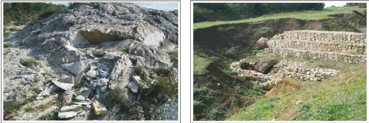
Figure 8 (à gauche) : La gélifraction sur la barre calcaire Figure 9 (à droite) : Seuil en pierre sèche détruite
