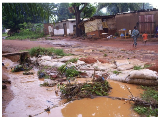
Photo 4 : Digue de protection des rues à Galabadja-Sinistré (cliché : Eténé, septembre 2010).
