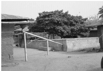
Photo 3 – Une gouttière connectée avec une citerne à Gbowèle. Cliché : Etene, octobre 2005
