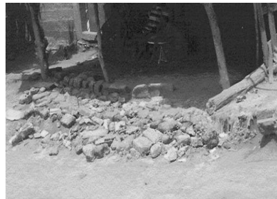
Photo 4 – Technique d'enrochement utilisée pour protéger une Concession à Dodomey. Cliché : Etene, octobre 2005
