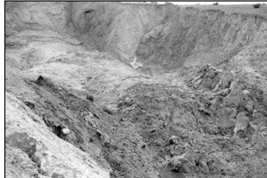
Photo 2 – Déclenchement d'un glissement-coulée lors d'un évènement pluviométrique exceptionnel
