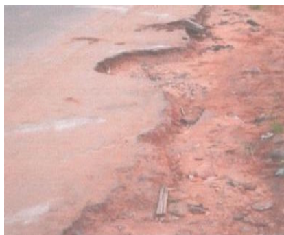
Photo 2 : Ravinement des abords d'une voie à Boy-rabe Cliché Eténé, septembre 2006 Source : Enquête de terrain, 2006
