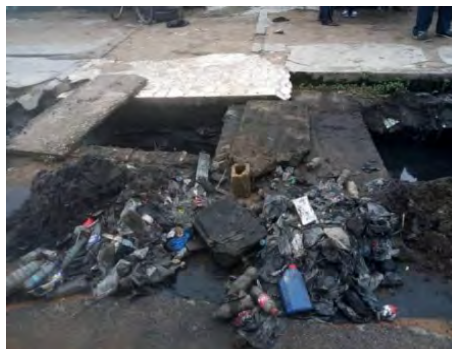
Photo 1: Caniveaux débouchés Prise de vue : Sekongo K. F., 2021
