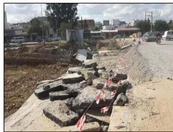
Figure 7. Route régionale n°4 ébréchée de 1,40 m au Km7 de la route Béni-Khalled- Korba
