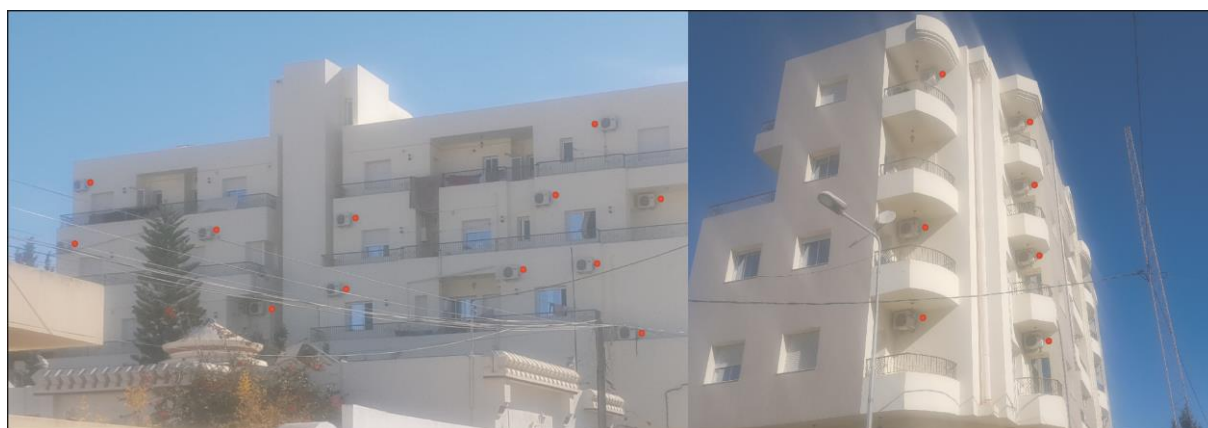
Figure2. Fort équipement en climatiseurs dans les bâtiments modernes des quartiers de Sfax ouest.
