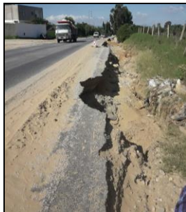
Figure 7. Route régionale n°4 ébréchée de 1,40 m au Km7 de la route Béni-Khalled- Korba
