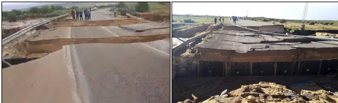
Figures 6a et 6b. Effondrement du pont-route sur l'oued Ouair entre Fériana et Majel Bel Abbes suite à la crue du 17 octobre 2018. À noter la nature très meuble du remblaiement employé sur les buses.
