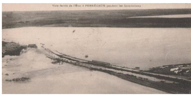
Voie ferrée pendant les inondations
