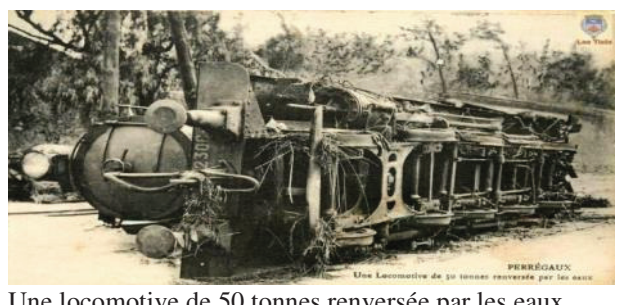
Une locomotive de 50 tonnes renversée par les eaux
