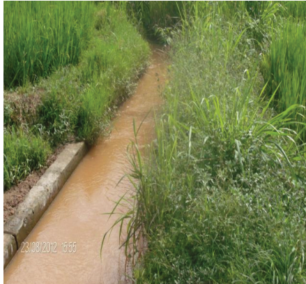
Photo 3. Drain de conduite d'eau vers le périmètre irrigué Prise de vue : Atchadé G., Octobre 2016
