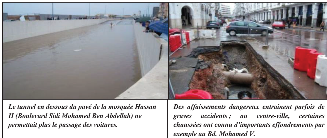
Fig. 4. Quelques dégâts au niveau de l'infrastructure de la ville
