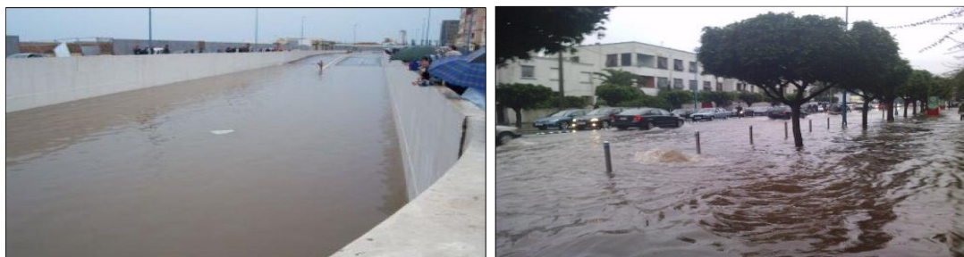
Figure 6. Paralysie de la route Hassan II (Boulevard Sidi Mohammed Ben Abdellah) (à gauche) et effet des crues du 30.11.2010 (Boulevard Zerktouni Casablanca) (à droite) (Source : https://www.yabiladi.com/ )
