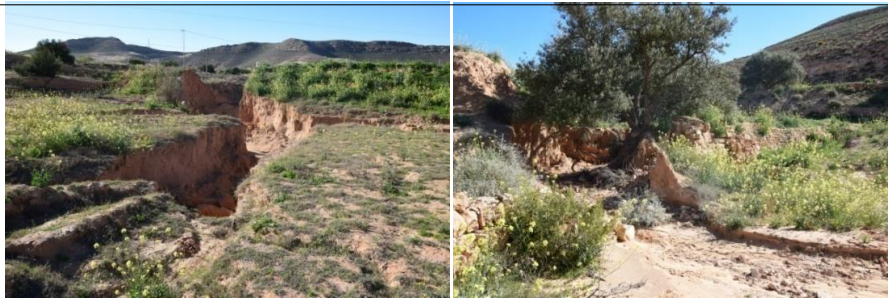
Figure 5. Echantreuve ouverte dans une tabia, prolifération du ravinement dans la surface d'un Jesr et déchaussement des implantations.
