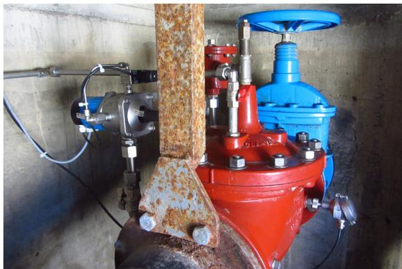
**Figure 2.** Sonde *e-FlowMeter* (à droite de l'image) insérée dans un coupe-pression du réseau d'irrigation, en amont du vignoble de Montana. Photo : Martin Calianno.
