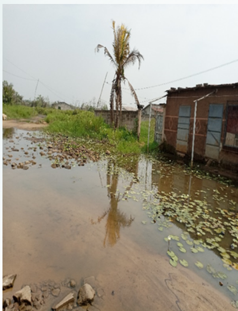
Maison et ateliers de travail inondés Localité de Mawuklo (Pahou - Bénin) 11 aout 2022 (Cliché photo : EW Vissin)
